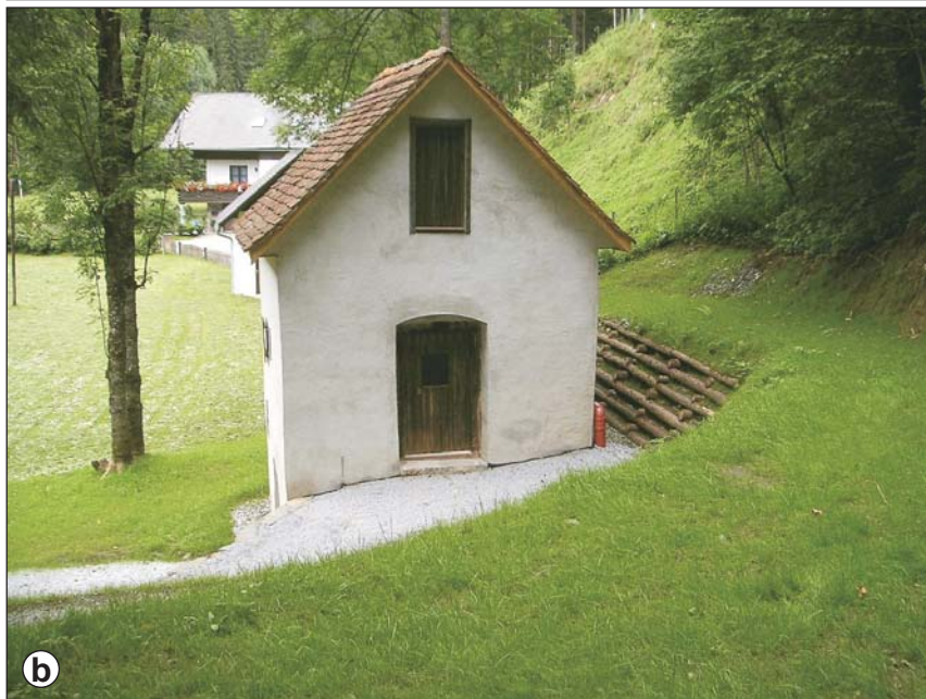
Abb. 12: Pulverturm von Arzberg während (a) und nach (b) der Restaurierung (Foto: L. WEBER 2004).
